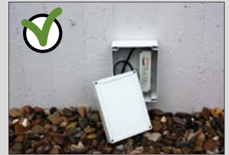
Korrekte Installation im Elektrogehäuse Correct installation inside the electrical cabinet Installation correcte dans le carter électronique
